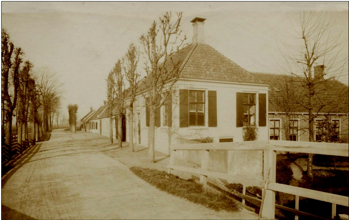
Herberg Ik Leer Nog aan de Hoge Rijndijk kijkend vanaf de brug over de Weipoortse Vliet, ca. 1890
