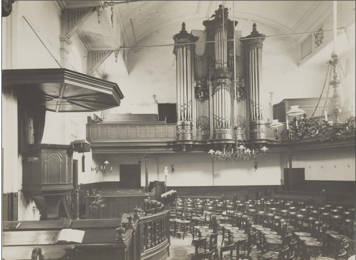
Het interieur van de Oude Grachtkerk na de verbouwing in 1901 door Jan Verhagen
