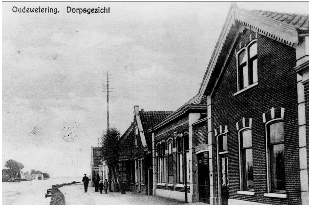
Het tweede gebouw van rechts was vroeger de school, het achterste huis links is nu Kerkstraat 26
