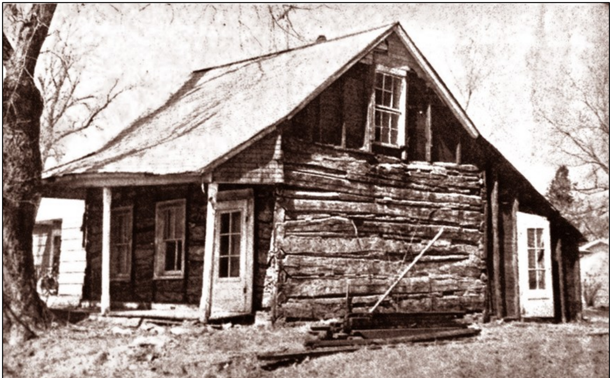
Het Thomas F. en Nancy Tuttle Log House te Pella, oorspronkelijk gebouwd in 1843
