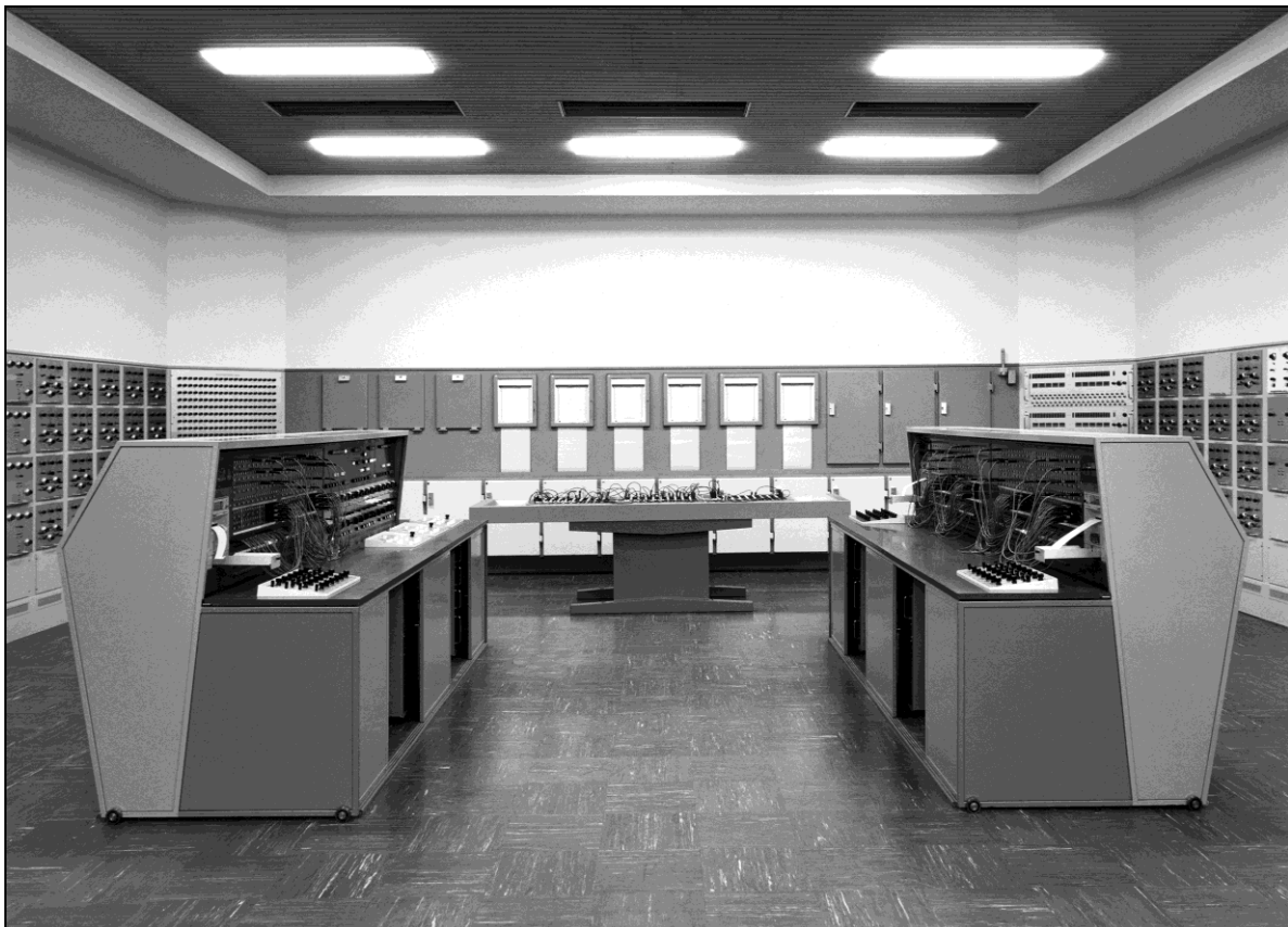
De Deltar (Delta Getij Analogon Rekenmachine)
